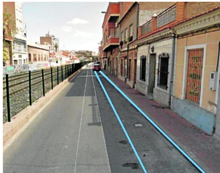
Viviendas afectadas por las obras en Barriomar.
