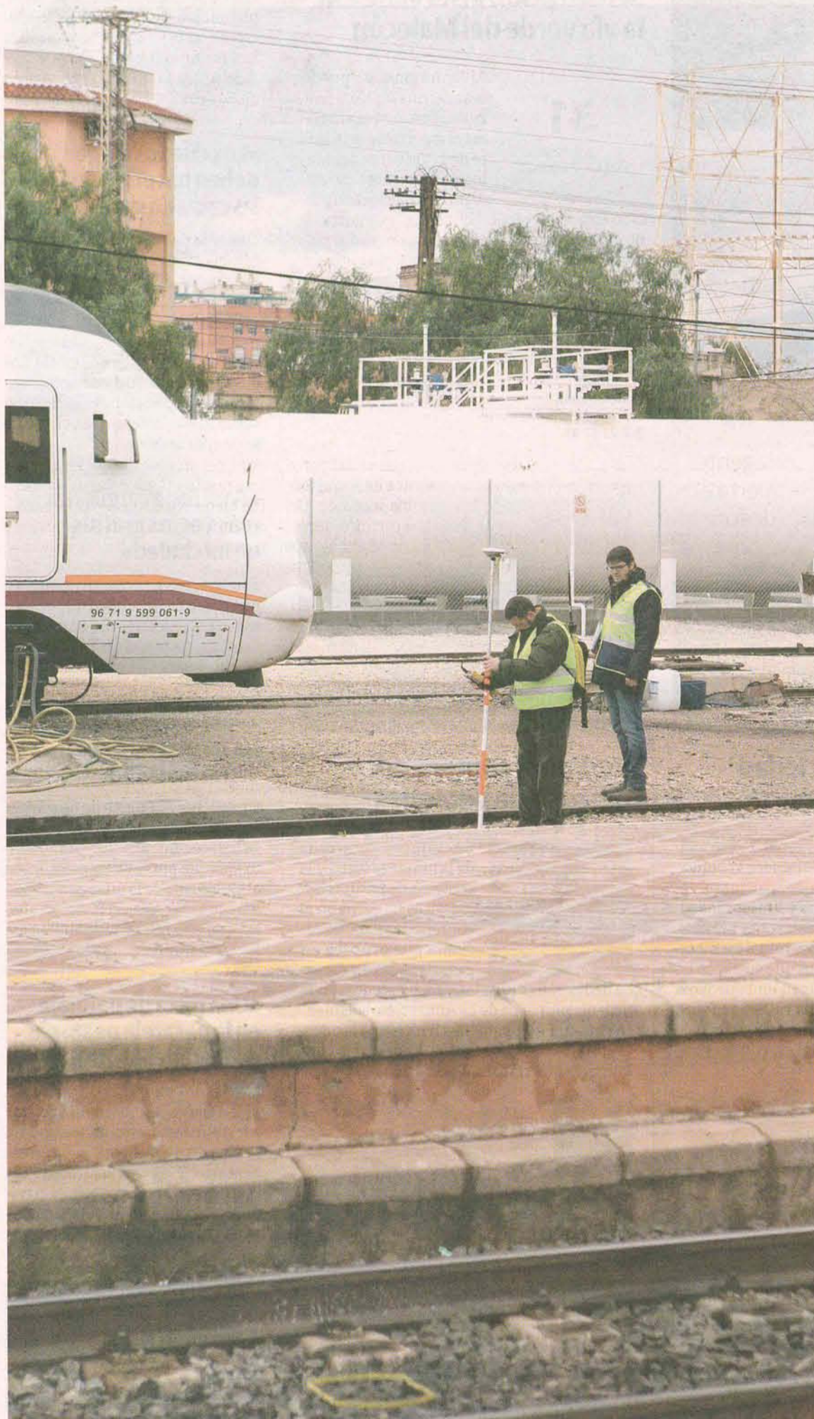
Vías del tren que serán soterradas en la estación del Carmen; al fondo, las calderas del gas. :: EDU BOTELLA
